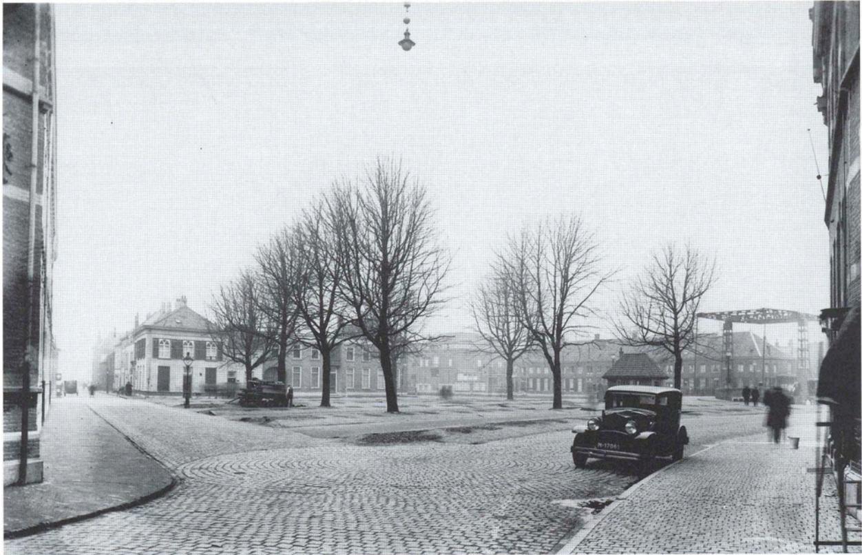
Opname uit 1933 van het Kardinaal van Rossumplein toen dit net niet meer als Veemarkt dienst deed, en nog zonder standbeeld. Links de verdwenen Hooge Nieuwstraat en bebouwing. Vandaag betonbouw van het Jeroen Bosch Ziekenhuis. (Foto: Stadsarchief, collectie Het Zuiden)
